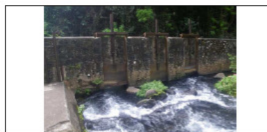
Vue de la prise d'eau
