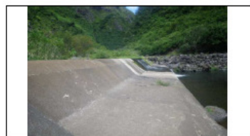
Vue transversale du seuil
