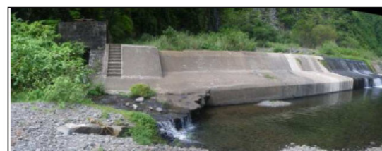
Vue d'ensemble du seuil
